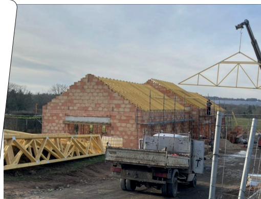
Construction maison médicale
